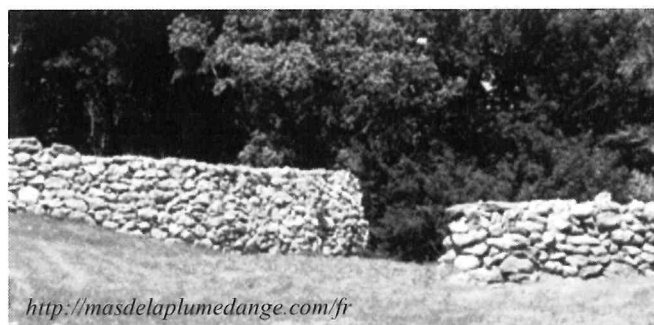
Mur de clôture
