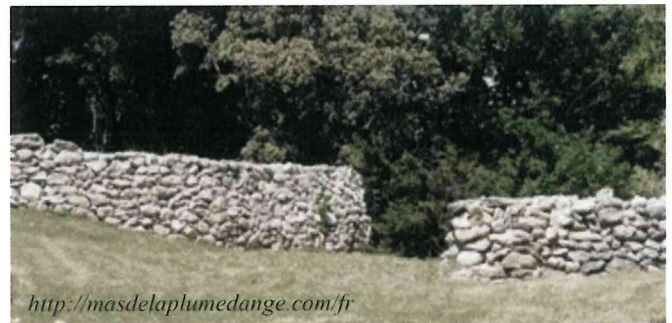
Mur de clôture
